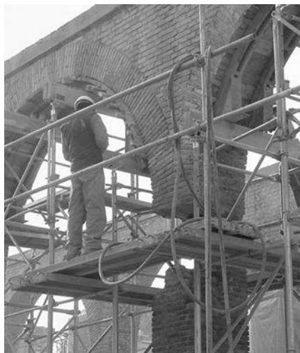
Figura 3: Perforación efectuada por máquina de micro-pilotaje para la inserción de tubos de acero de refuerzo visible en pilar dañado del Tercer Depósito en Avda. de Islas Filipinas [P. Candela Soto en madri+d www.madrimasd.org ]
