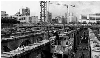
Figura 5: Inserción de armados de refuerzo en pilares del Cuarto Depósito [L. Casas López-Amor 2005]
