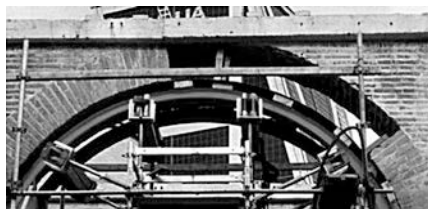
Figura 4: Reconstrucción de arco de fábrica de ladrillo en Cuarto Depósito. [L. Casas López-Amor 2005]
